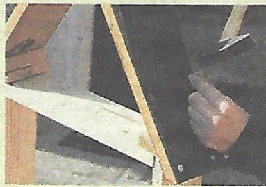
lappend über den Dachfirst legen und mit Nägeln befestigen. Auf der anderen Seite die Dachpappe anpassen und ebenfalls fixieren.
